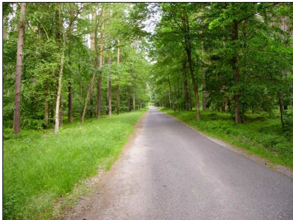
Nr. 1a – Zufahrt von L 16 bis Parkplatz Tornowsee
